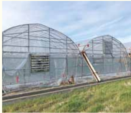
ハウスに設置された換気扇と電動シャッター
