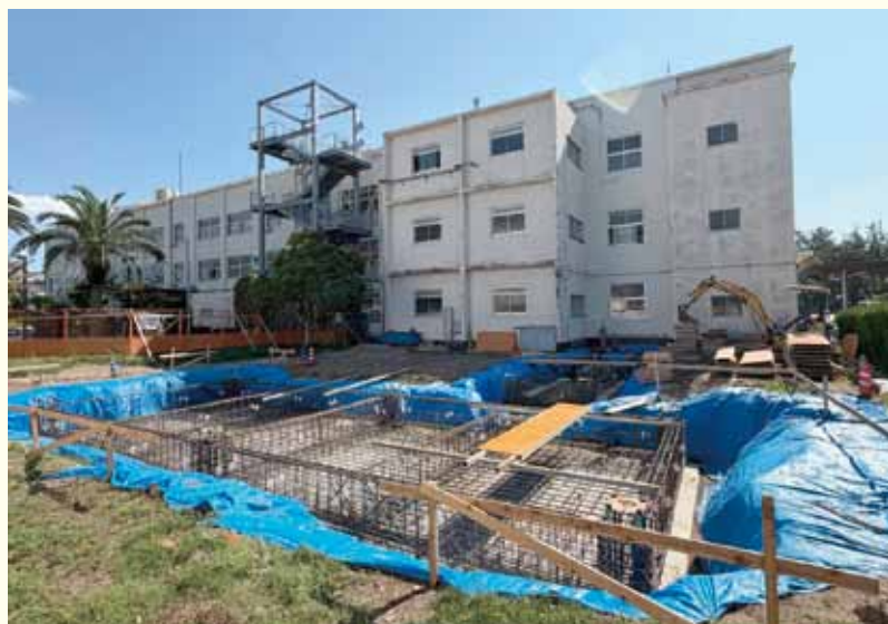
現在進行中のスロープ工事現場
