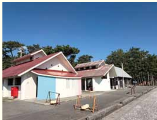
改修予定のトイレ棟と炊事棟
