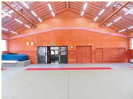
空調設備が設置される松洋中学校武道場
