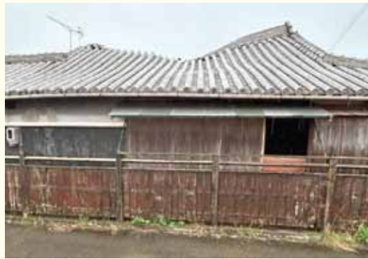
撤去した空き家
