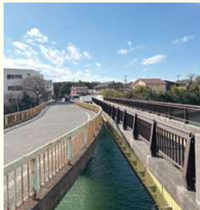
▲尾ノ上橋歩道橋
