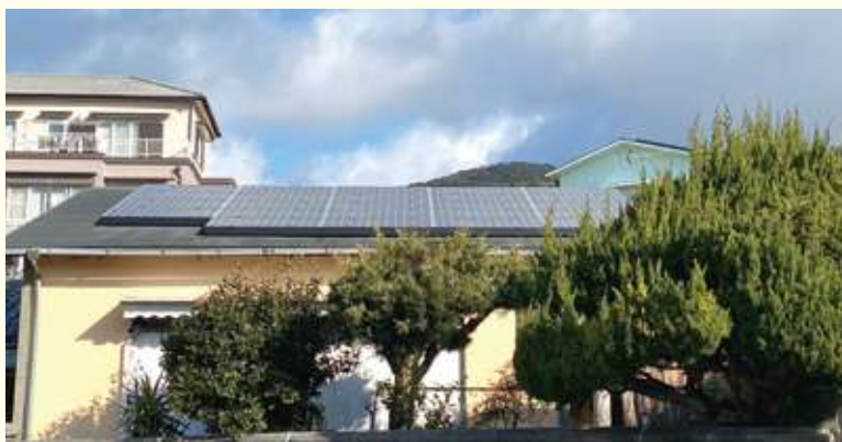
▲屋根の上に設置された太陽光パネル
