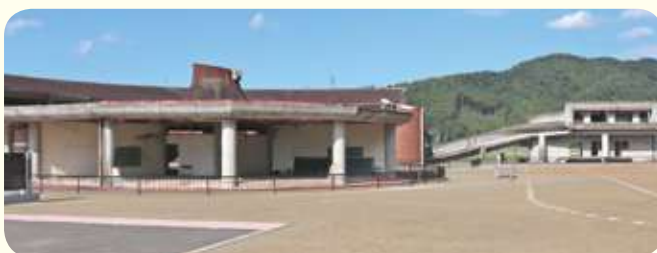
▲震災遺構 大川小学校
