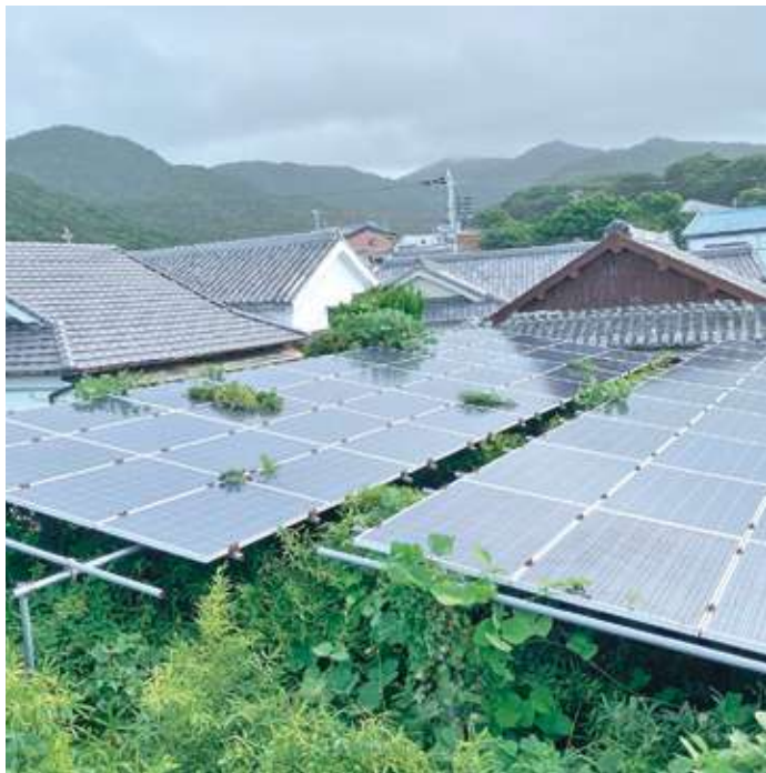
▲民家の真横に設置している現状
