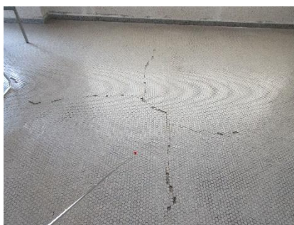
床材の亀裂
