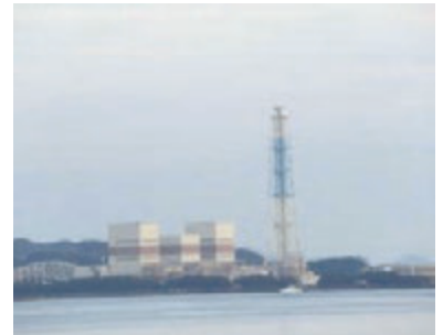
▲高さ200mの火力発電所の煙突
