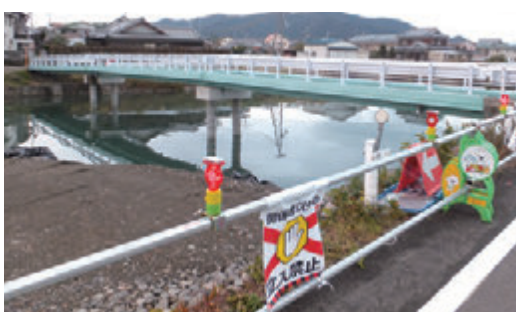
▲一次撤去前の寺田橋
