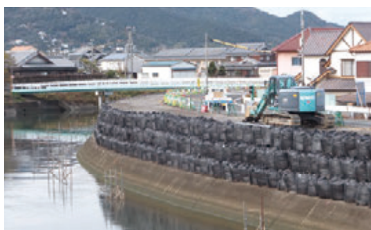
▲現在の改修工事の様子
