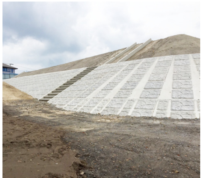
▲建設中の松原高台（4月1日現在）
