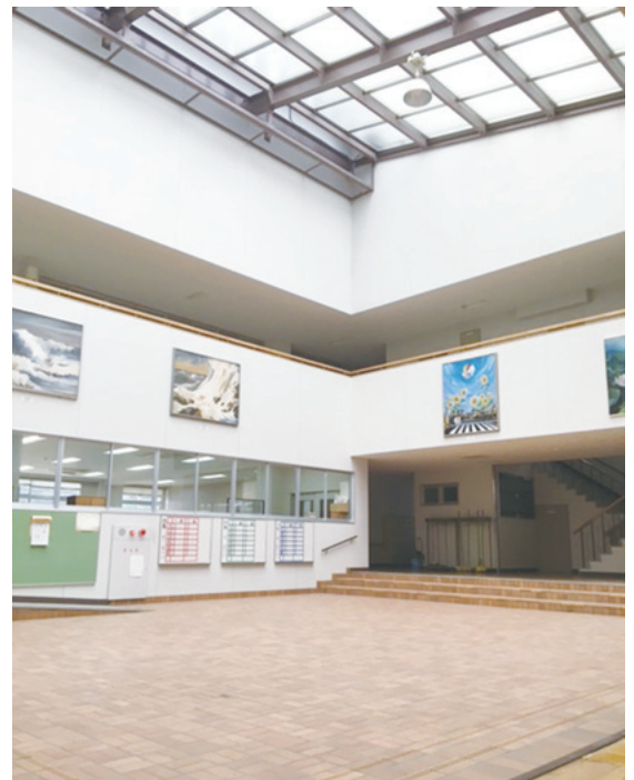
▲雨漏りのするオープンスペース
