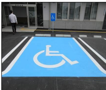
障害者用駐車スペースの設置
