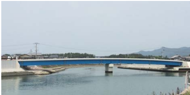
▲竣工を待つ西川大橋
