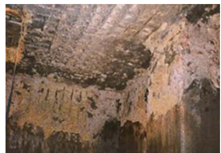
▲水槽コンクリートの状況
