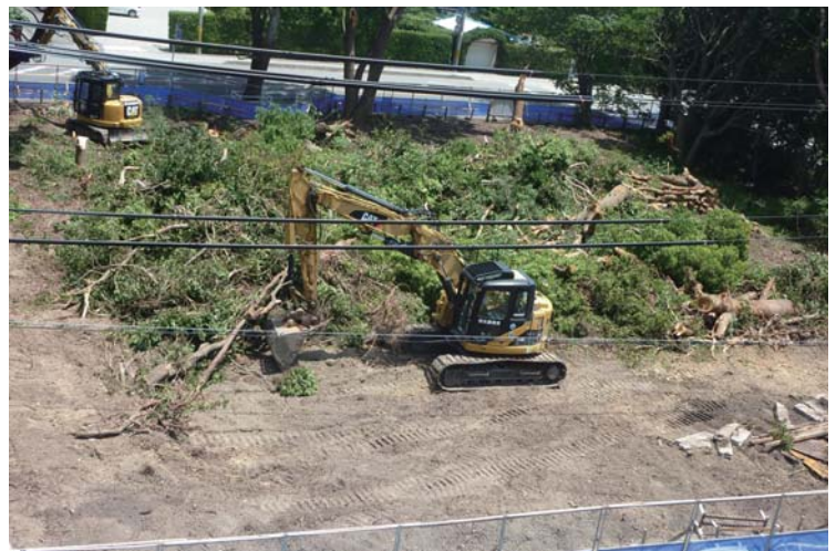
▲始まった庁舎増築工事
