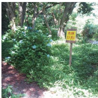
▲遊歩道近くの処理施設
