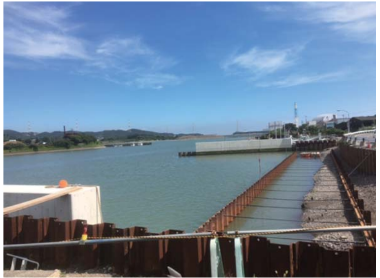
▲建設中の係留施設
