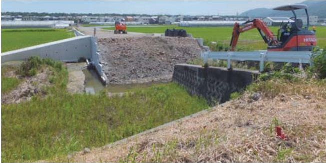
▲建設中の吉原上田井線
