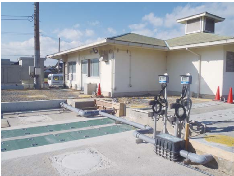
▲改修後の和田処理場
