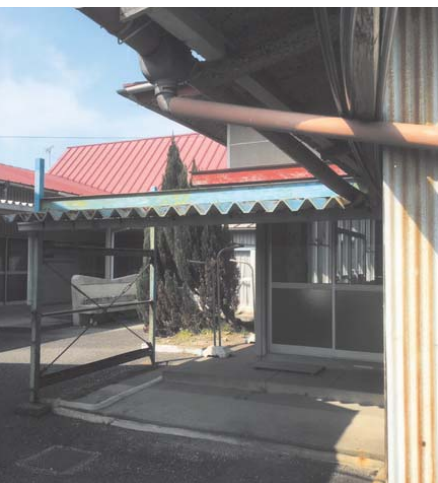
▲危険が指摘されている老朽施設
