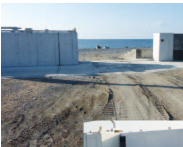
りっこう ▲和田の陸閘 (開放時)
