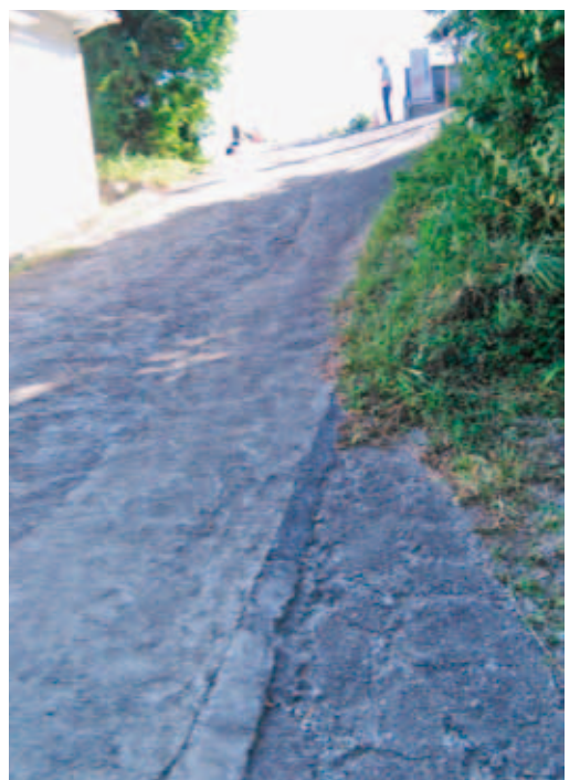
▲この急傾斜を工事車両が通る
